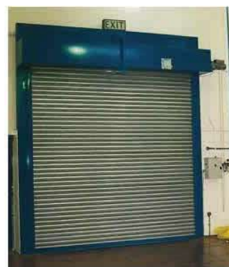
Roller shutter fire door
