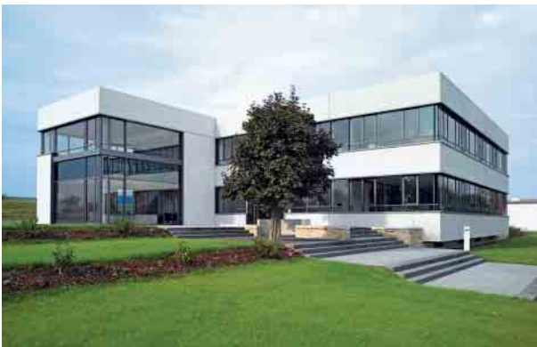
Sebia Bürogebäude, Fulda, Deutschland Sebia Offices, Fulda, Germany
