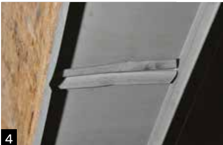
4 Install adjoining soffit.
