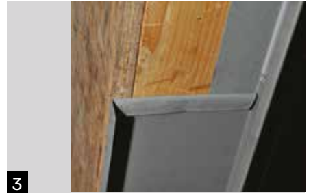
3 Install soffit.
