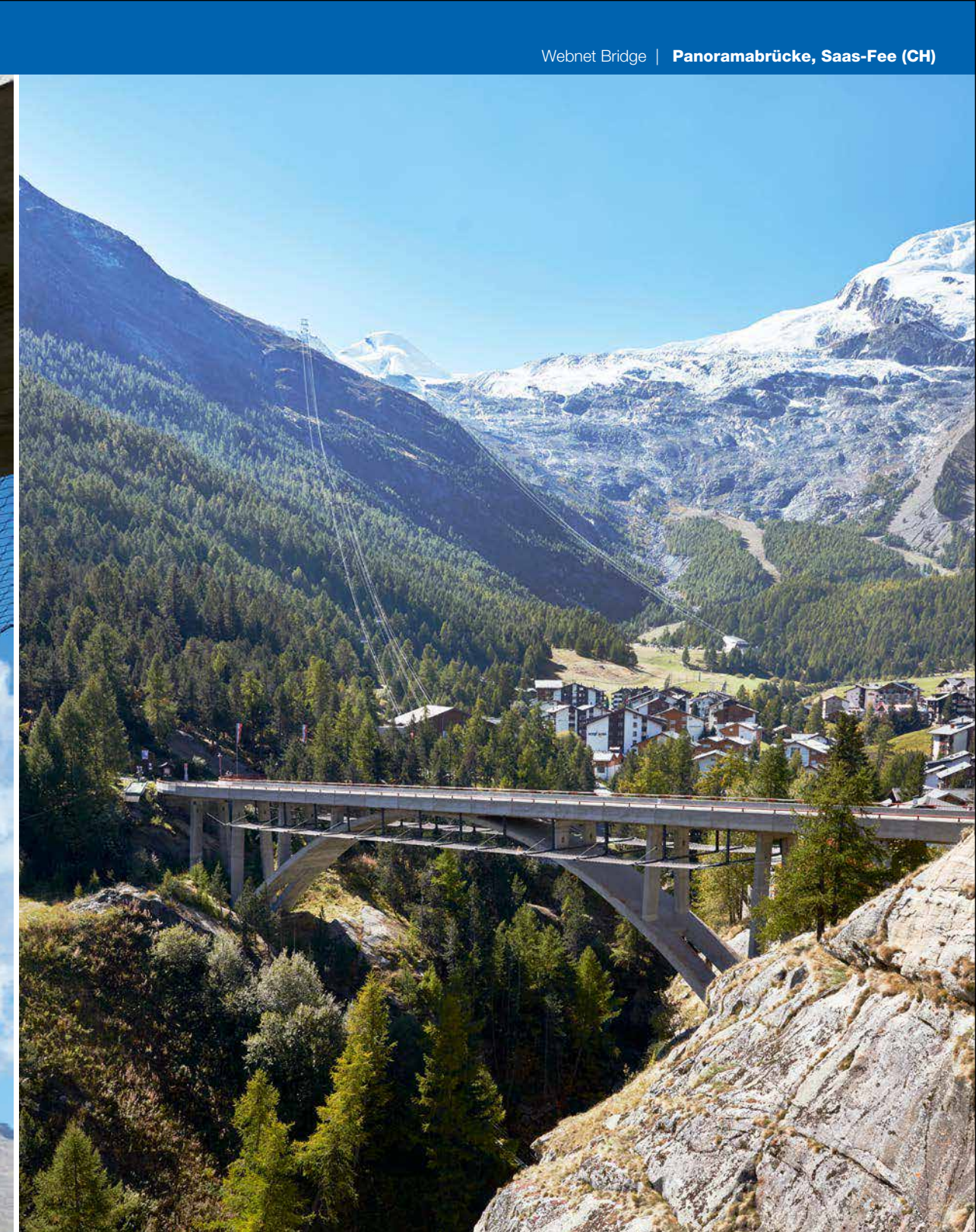
Panoramabrücke, Saas-Fee (CH)
