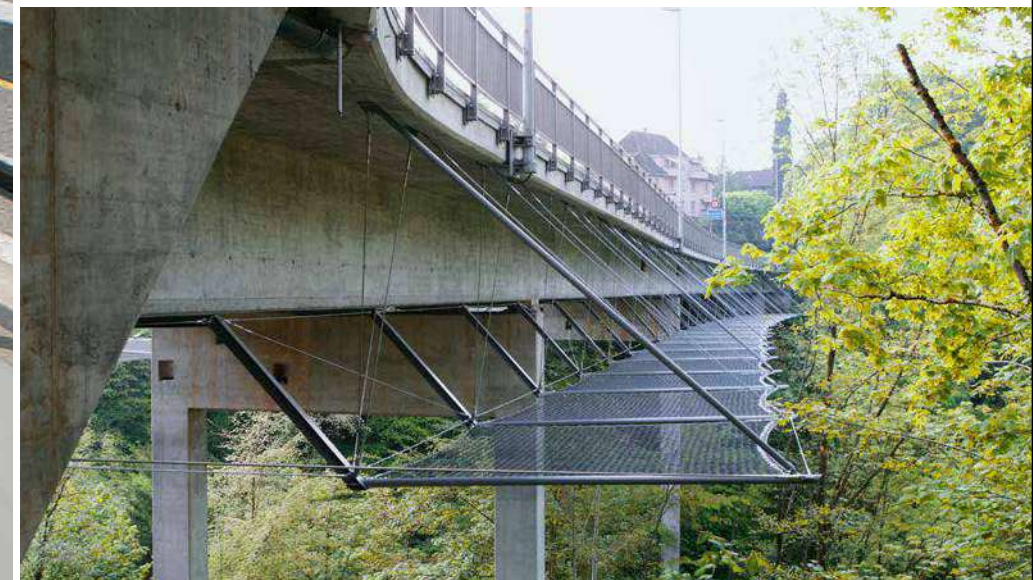
Rotbachbrücke, Rothenburg (CH)
