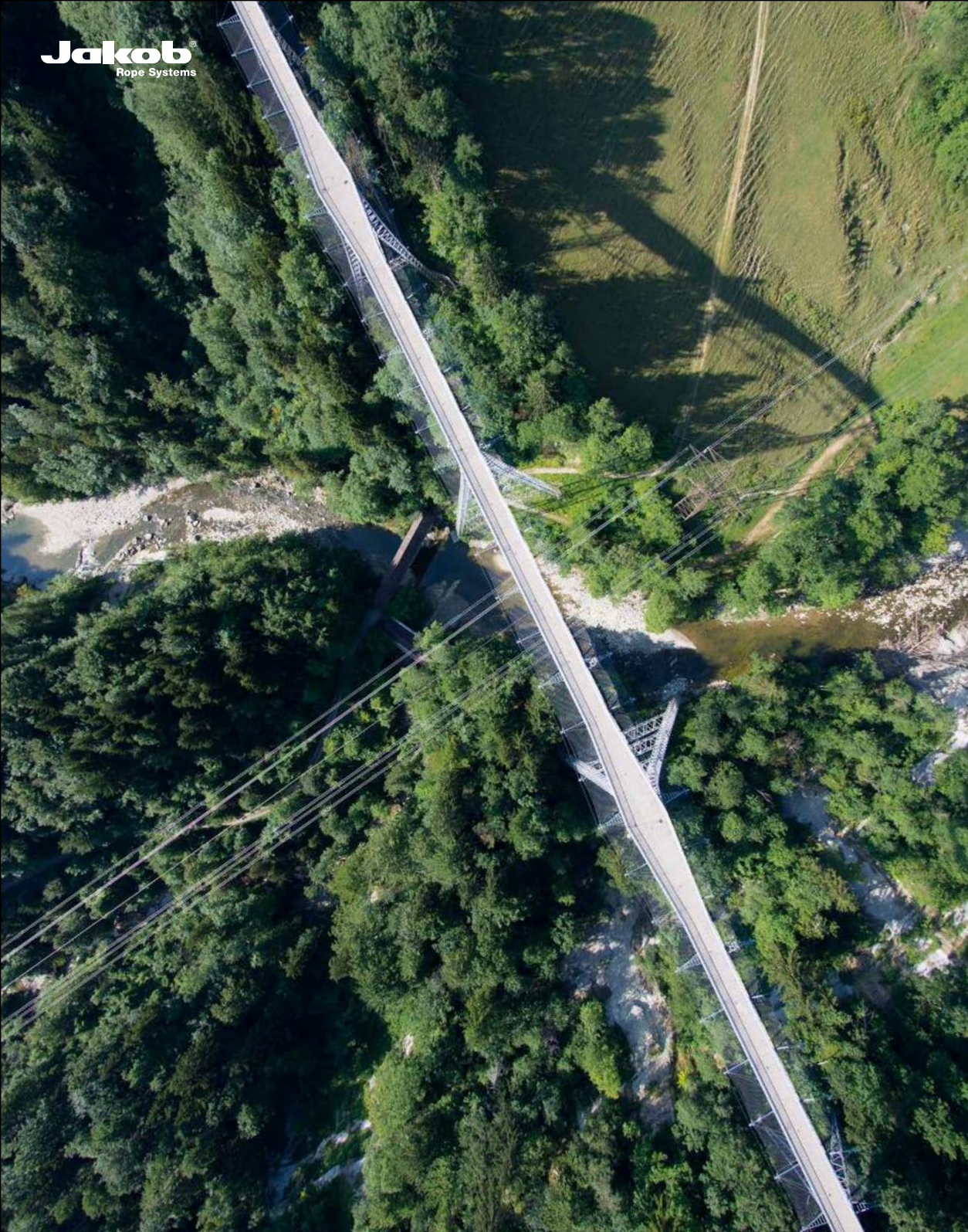
Hagggenbrücke, St. Gallen (CH)
